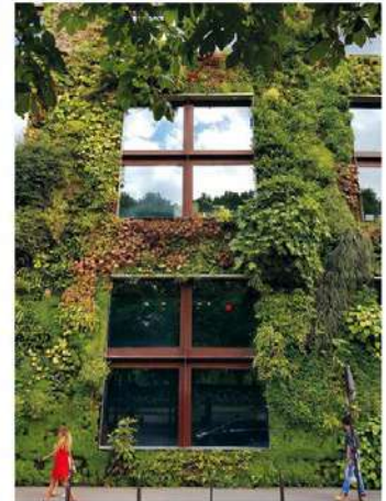
Le mur végétal de musée du quel Brecht, 15000 plantes, plus de 200 espèces de végétaux sur 22 m de haut, et 47 m de large, sur 1534 m 2 de mur. Façade végétalisée horizontale. Sa végétalisation en 2017 avait une complexité requise par l'architecture de la structure portante.
