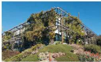
Le bâtiment des services de la gare de San Francisco, Californie. Les façades sont protégées par pergola et des brises-soleil câbles qui constituent une structure support en trois dimensions pour les grimpantes.
